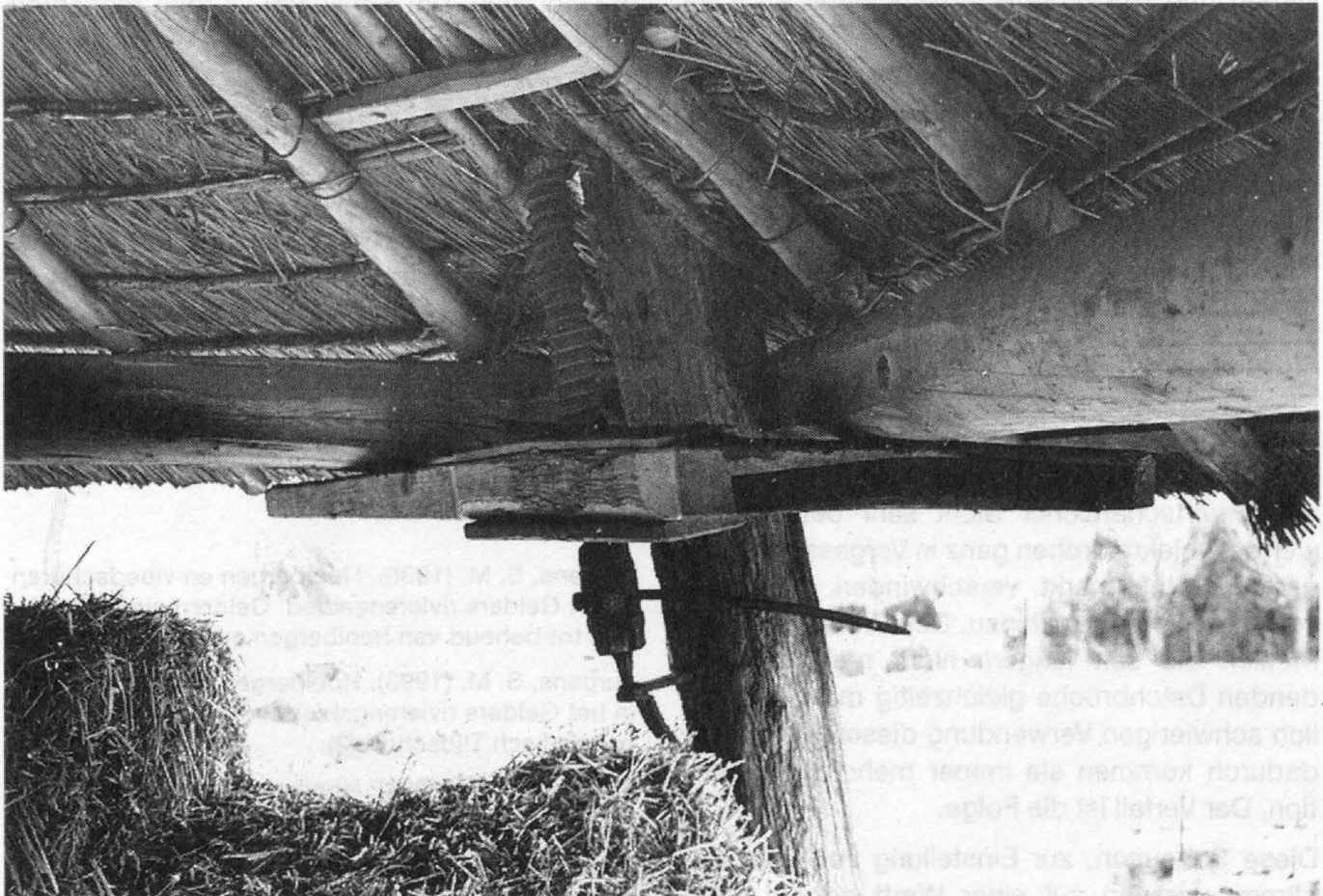
Abb. 2 Sog. „Bergwinde“, Vorrichtung zur Höheneinstellung des Daches (Foto: T. M. van Engers)
