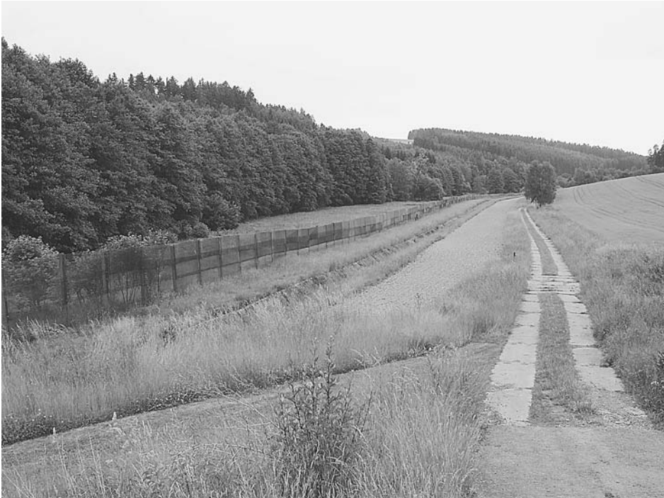
Abb. 1: Reste der Grenzanlagen, wie hier nahe Mödlareuth, sind nur noch vereinzelt zu finden: Kolonnenweg, Kontrollstreifen, Kfz-Sperrgraben, vordere Grenzsicherungssperranlage (von rechts nach links)
