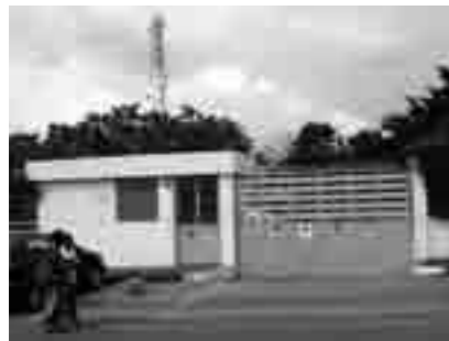
6 Eingang zum Gebäude der GTZ in Abidjan.
