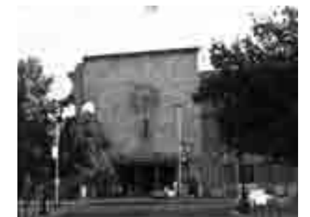
3 Der beim Erdbeben 2001 teilweise zerstörte Bahnhof von Skopje (inzwischen Museum)
